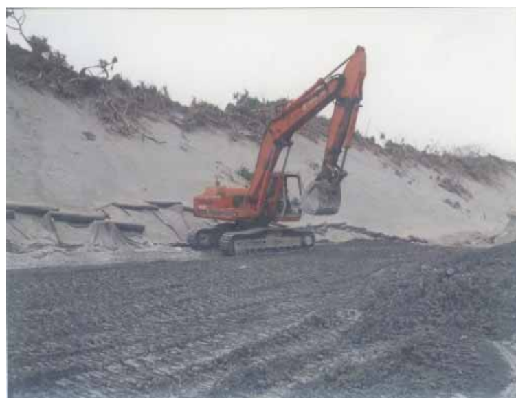
圖 7.9 挖土機來回壓實固化層
