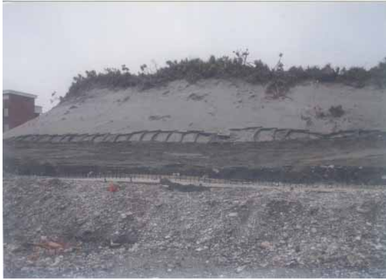
圖 7.6 地工織物鋪設
