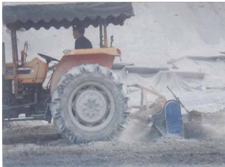
圖 7.8 耕耘機來回混拌花崗石污泥和固化劑
