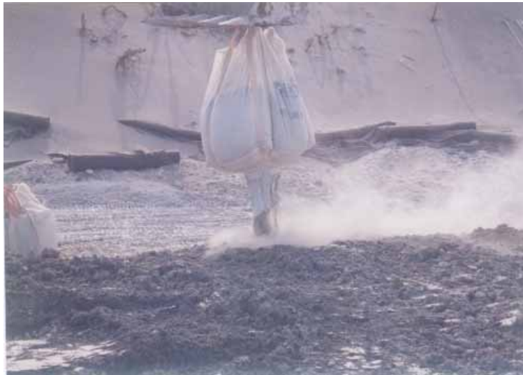
圖 7.7 固化劑散布於石材污泥表面
