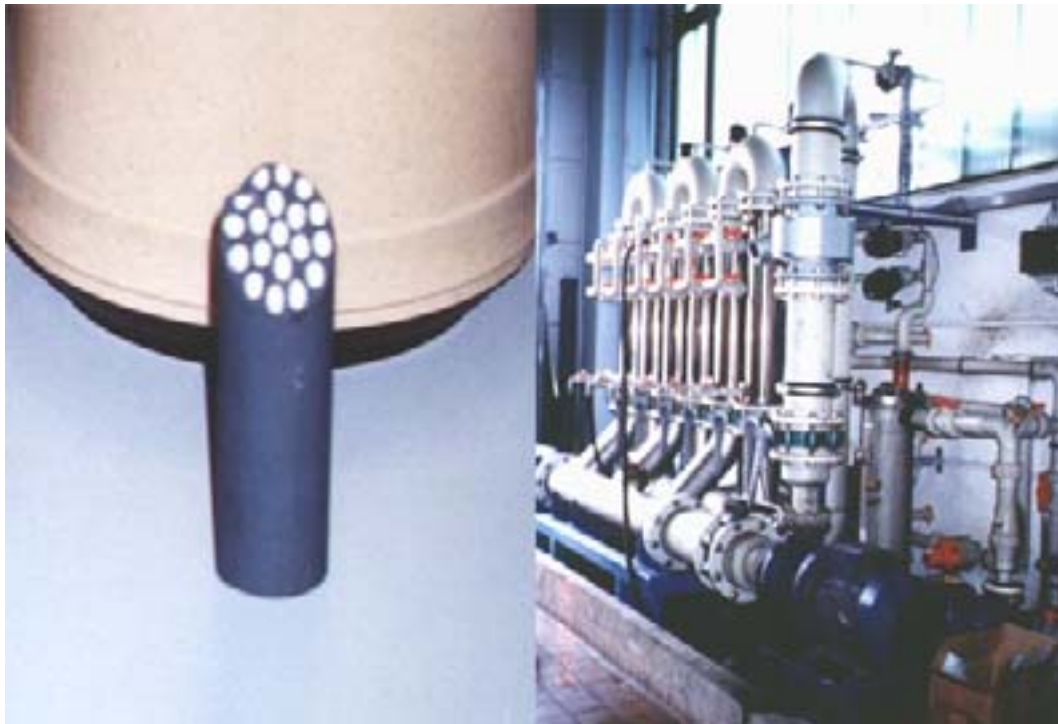
照片 3.4 無機膜陶瓷薄膜超過濾處理系統，左邊為過濾膜管照片
