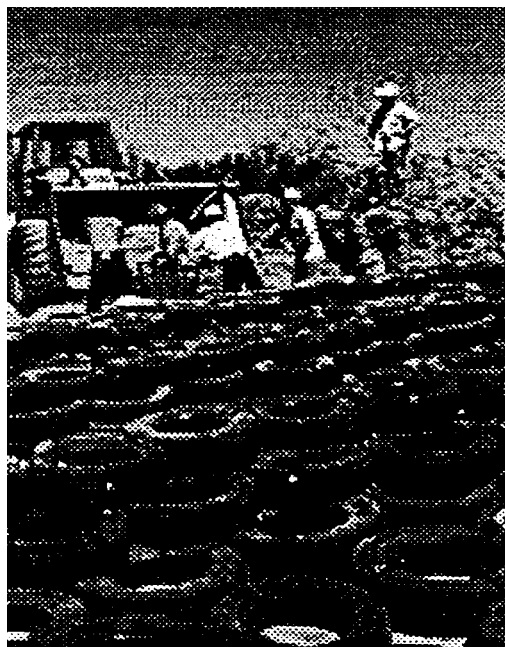
圖 3.4 廢輪胎用作人工土堤 (9)
