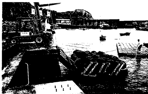
圖 3.3 廢輪胎與浮筒製作浮動碼頭 (7)
