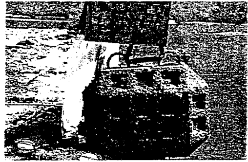
三重縣古和浦漁港內人工魚礁設置情形(1998)
