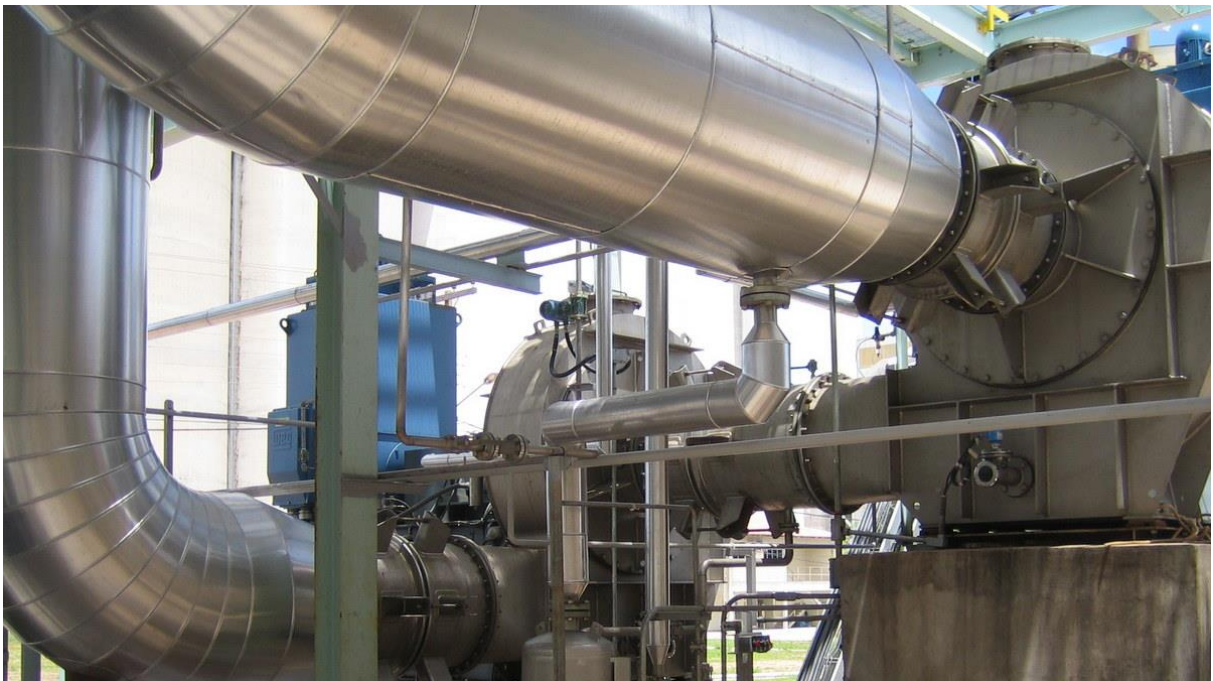
圖 3.2-4 德國 GEA 公司機械式蒸汽再壓縮技術應用實廠圖片
