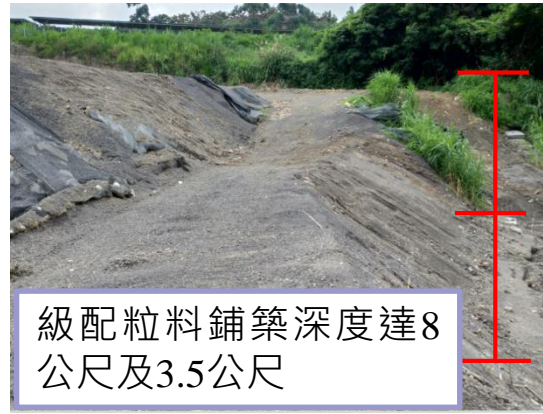
CLSM開挖回填寬度近似路寬，深度達3.5公尺
