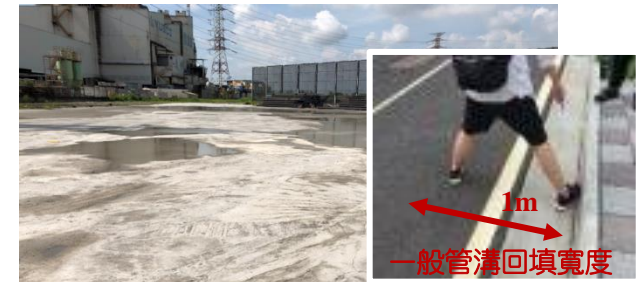
CLSM開挖回填寬度近似路寬，深度達3.5公尺
