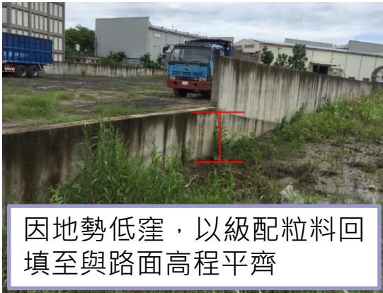
級配粒料鋪築深度達8公尺及3.5公尺
