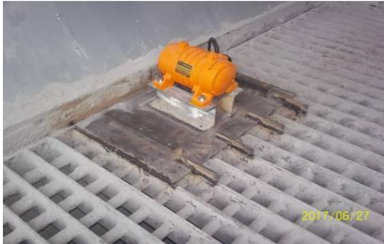
圖 3.3-3 卸料坑格柵加裝振動器
