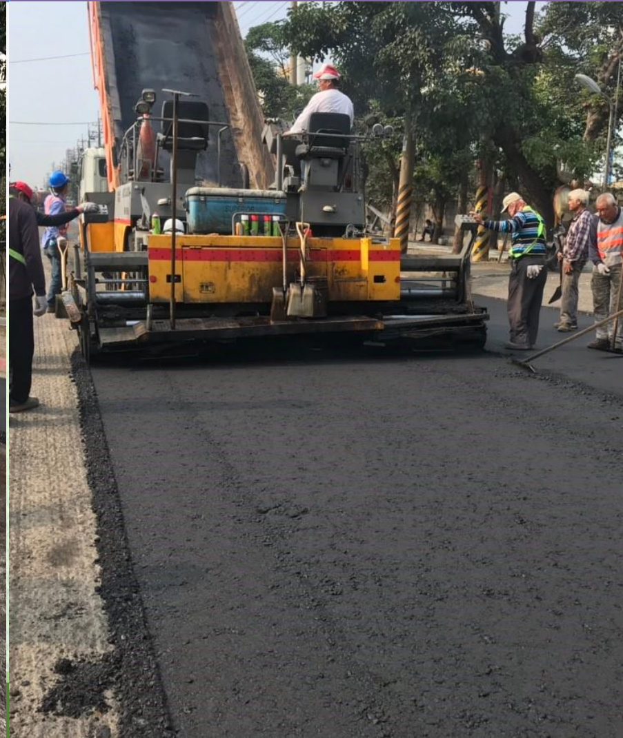
瀝青混凝土鋪築
