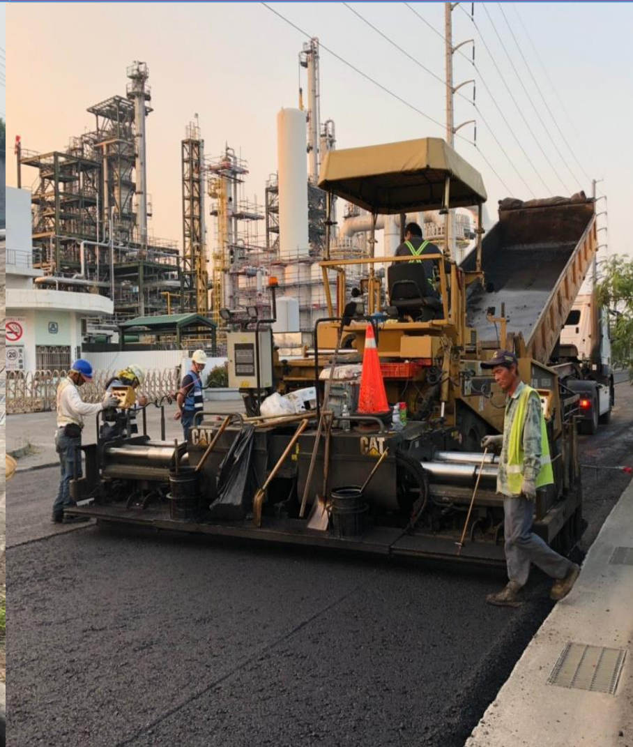
瀝青混凝土鋪築
