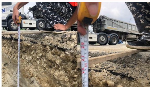
開挖深度量測
