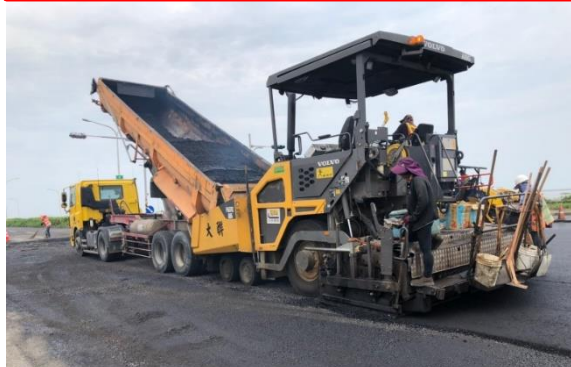
轉爐石瀝青混凝土鋪設
