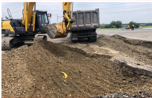
舊有基底層挖除作業
