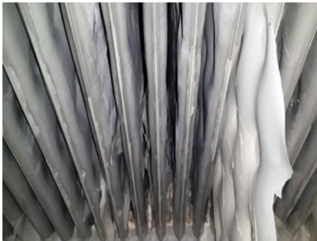
圖 7 結垢物運轉自行剝落
