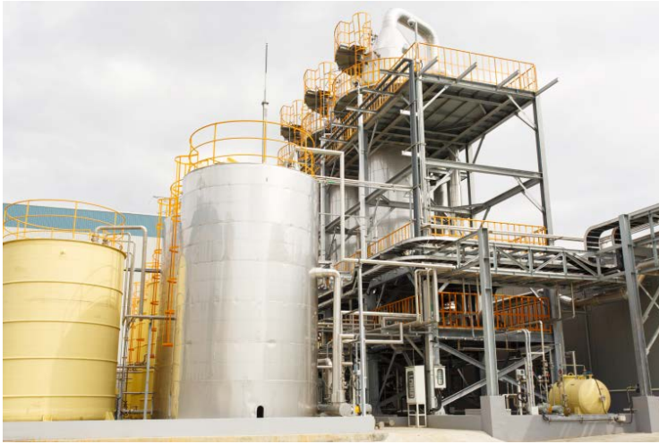
圖 8 完工的蒸發罐設備
