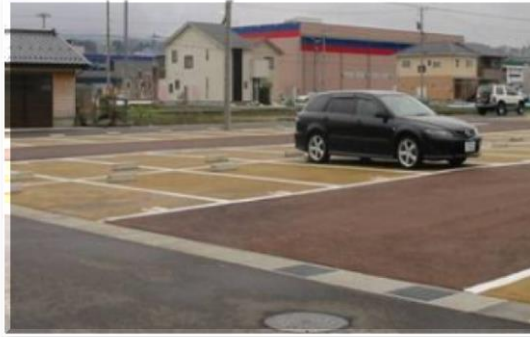
圖 4 日本鋪設保水鋪面之停車場 (石川縣道路安全檢討委員會, 2016)
