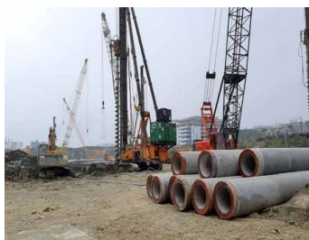
科技產業新建廠房
